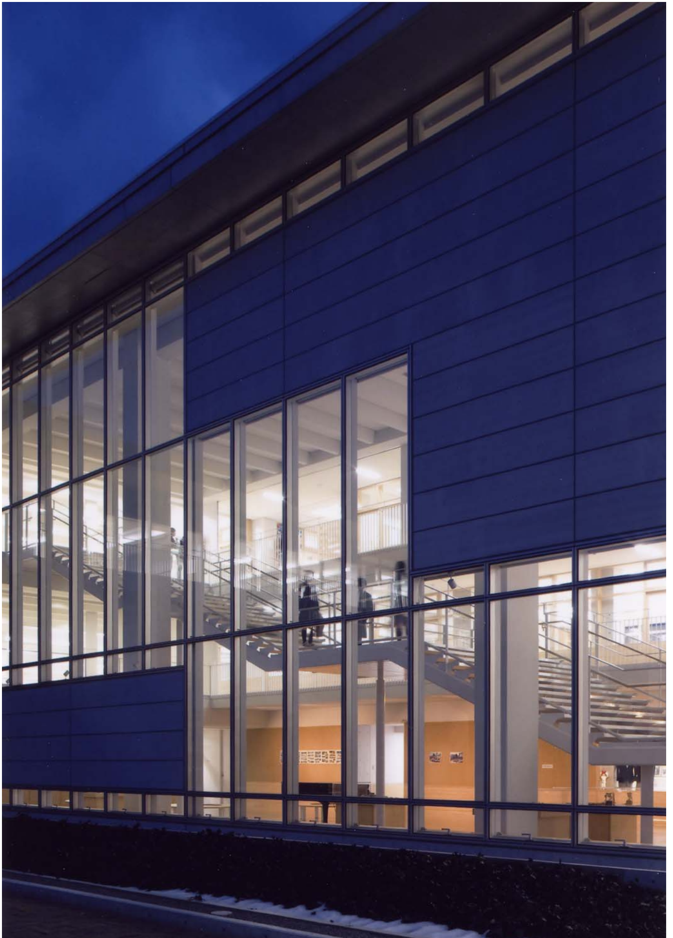
中庭からEASTホールをみる view from courtyard
