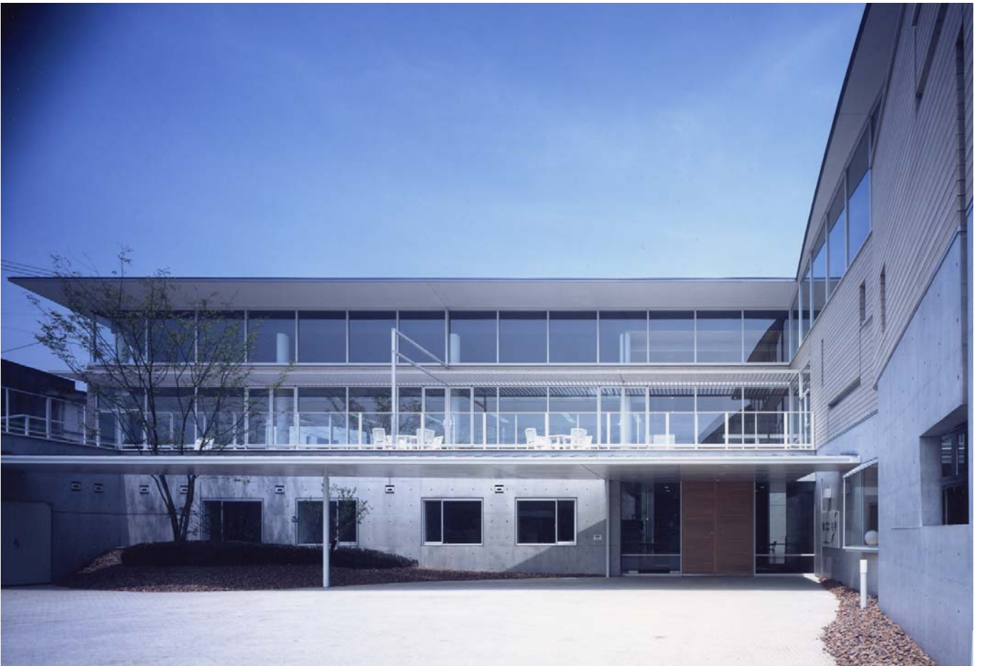
エントランス entrance
