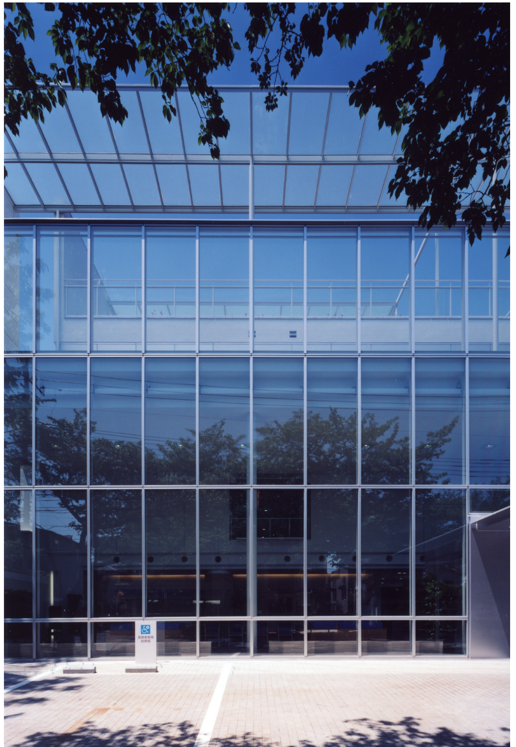
ファサード facade
