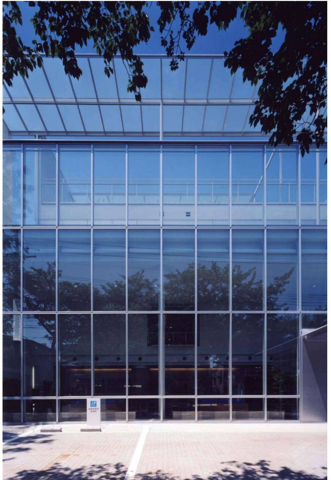
ファサード facade
