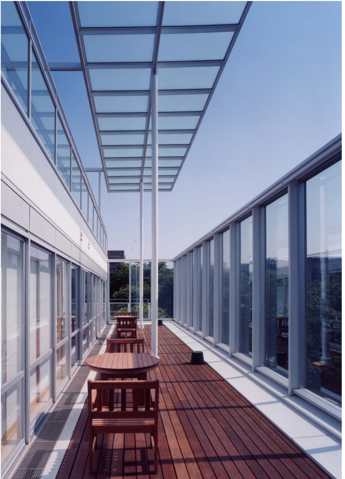
ルーフテラス roof terrace
